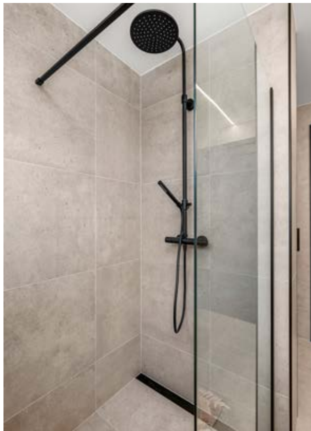
Dusjsone på bad
