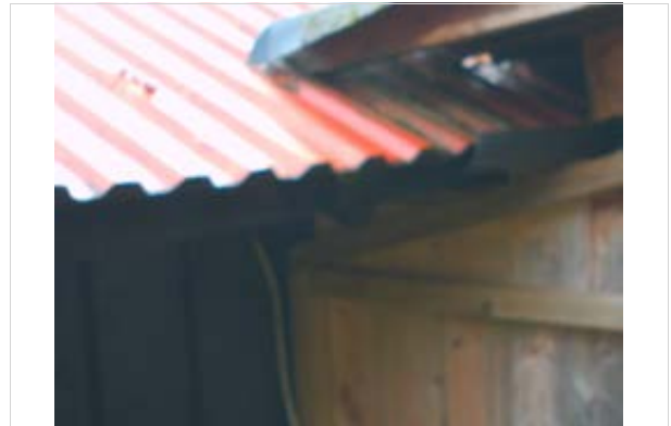
Overgang mellom papp tekking og takplater
