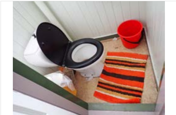
Toalettrommet har belegg på gulvet, panelte vegger og wc.
