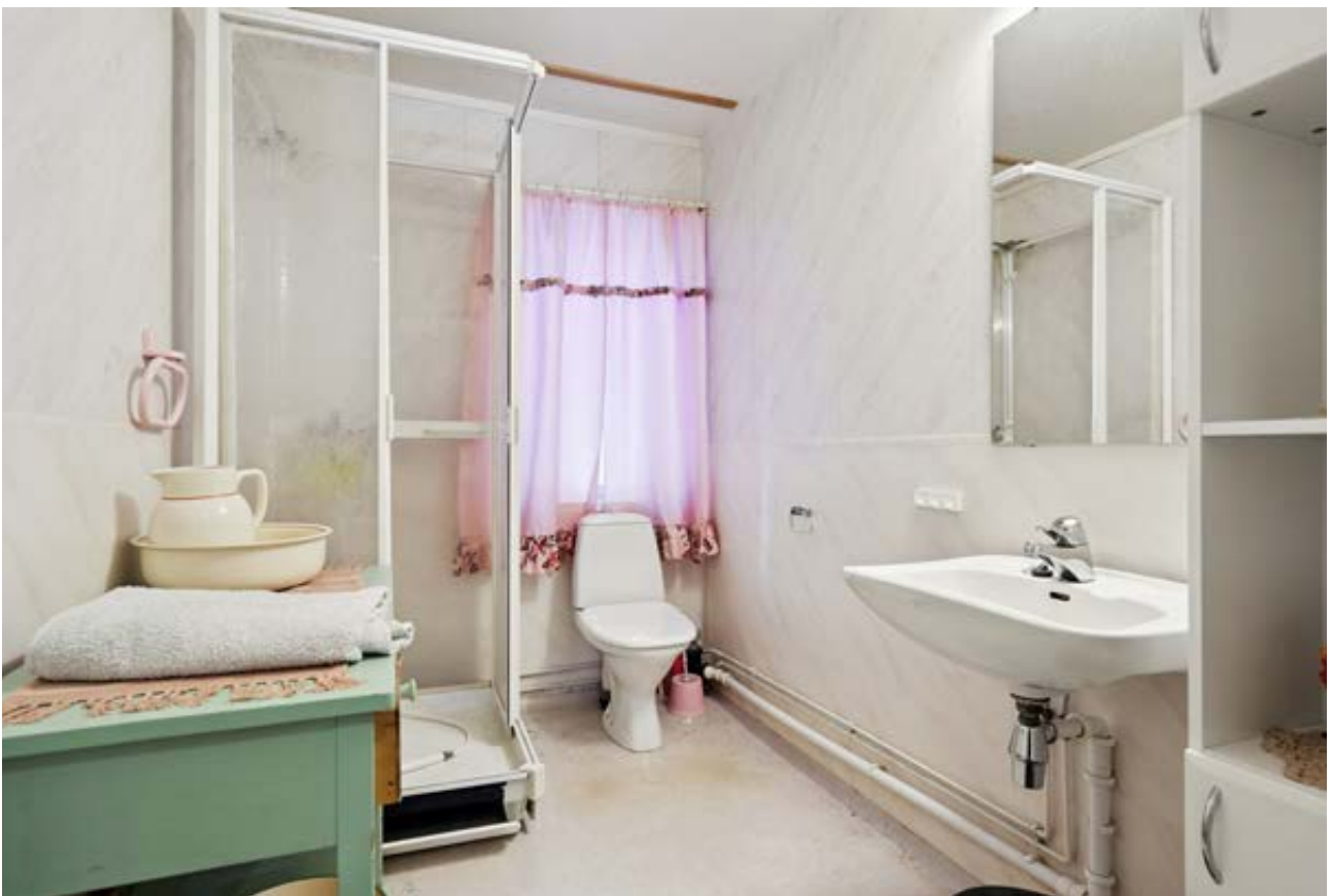
Bad 2 etasje hovedbygg
