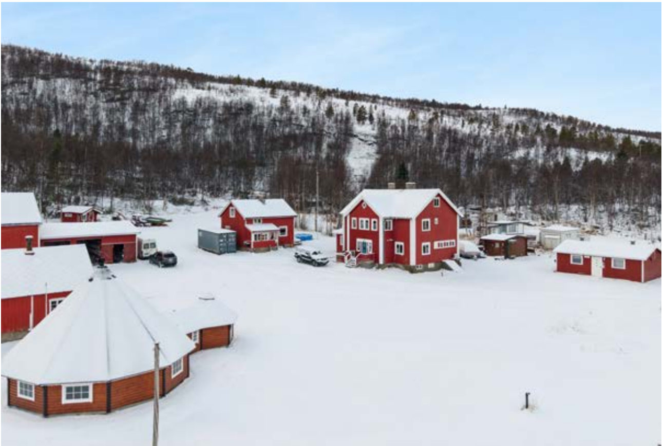
Dronebilde over deler av bygningsmassen
