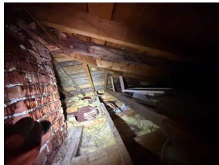
Oversiktsbilde av kaldloftet i delen fra byggeår.
