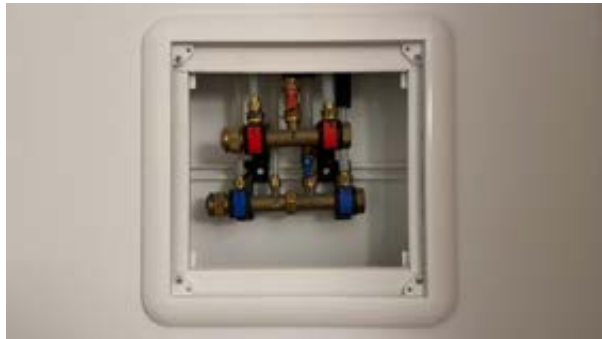
Sentralskap mangler kursoversikt og sprutdeksel.
