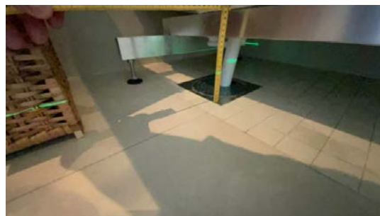
Høydeforskjell (ved sluk)
