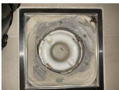
Synlig membran bak feilist
