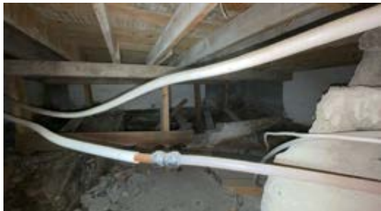
Krypkjeller under deler av boligen med begrenset tilgang.
