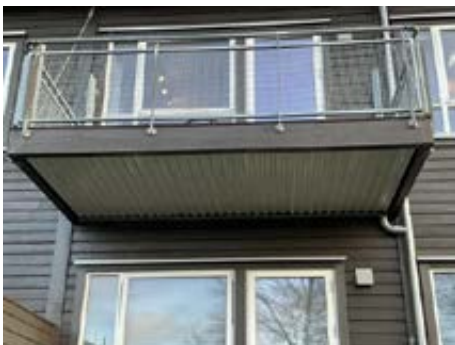
Overflatevann er tilkoblet avløp.
