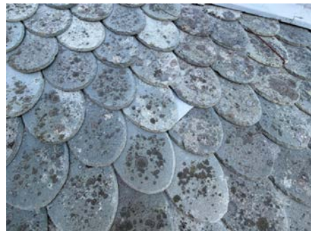
Lagt inn metallapper som tetting der det er åpninger mellom steinene.
