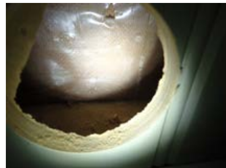
Viser plast i konstruksjon
