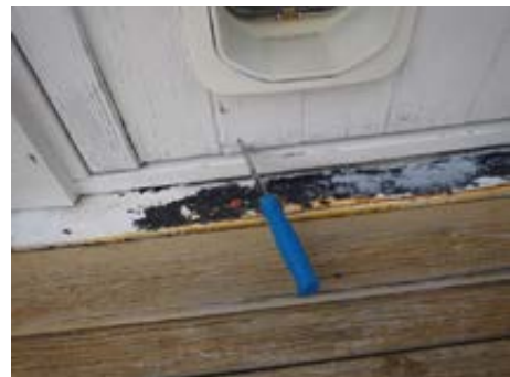
Skade i balkongdør stue
