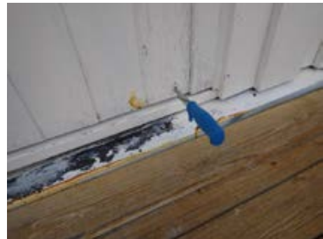
Skade i balkongdør stue
