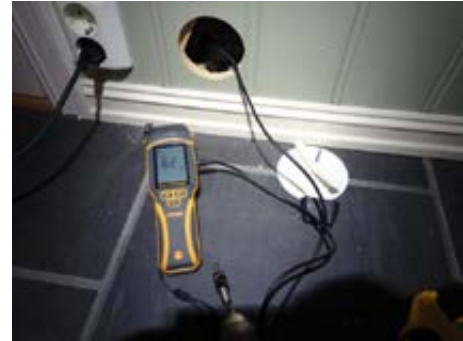
Målt tørt i treverk
