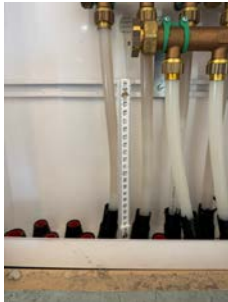
Meter plassert inne i avløpsrør til den stoppet.
