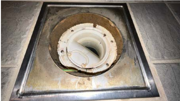
Kontroll av sluk.
