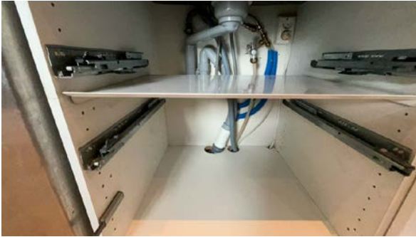
Besiktigelse av røropplegg.
