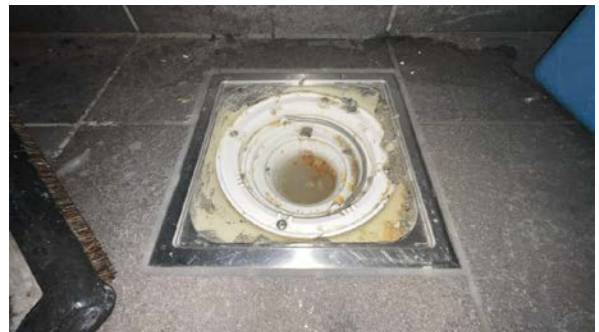
Kontroll av sluk.
