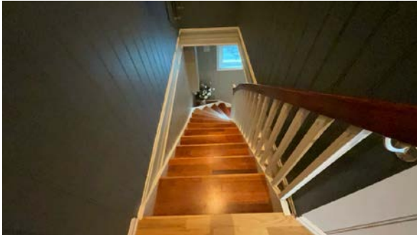
Besiktigelse av trapp.
