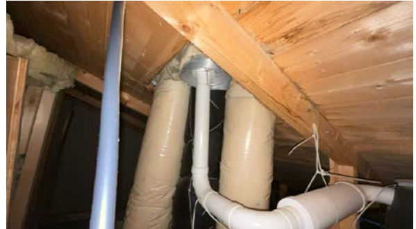
Kontroll rundt rørgjennomføringer.
