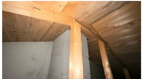
Kontroll rundt pipeløp.
