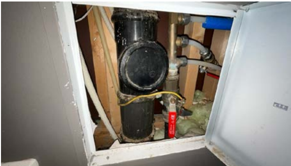
Besiktigelse av røropplegg.
