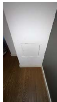
Ildfast plate mangler på gulvet under sotluke/feieluke på pipe.
