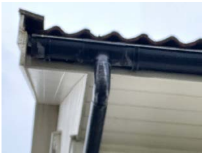
Skade/lekkasje fra nedløp mot gårdsrom TG 3.
