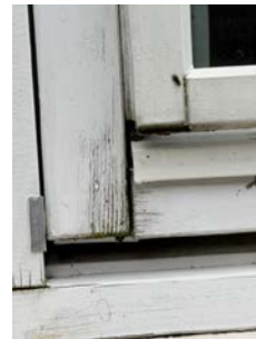
Glippe i sammenføyning på ramme. Bør undersøkes nærmere og eventuell utbedring foretas.
