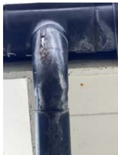
Skade/lekkasje fra nedløp mot gårdsrom TG 3.
