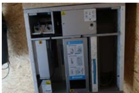
Flexit UNI 3 R balansert ventilasjonsanlegg
