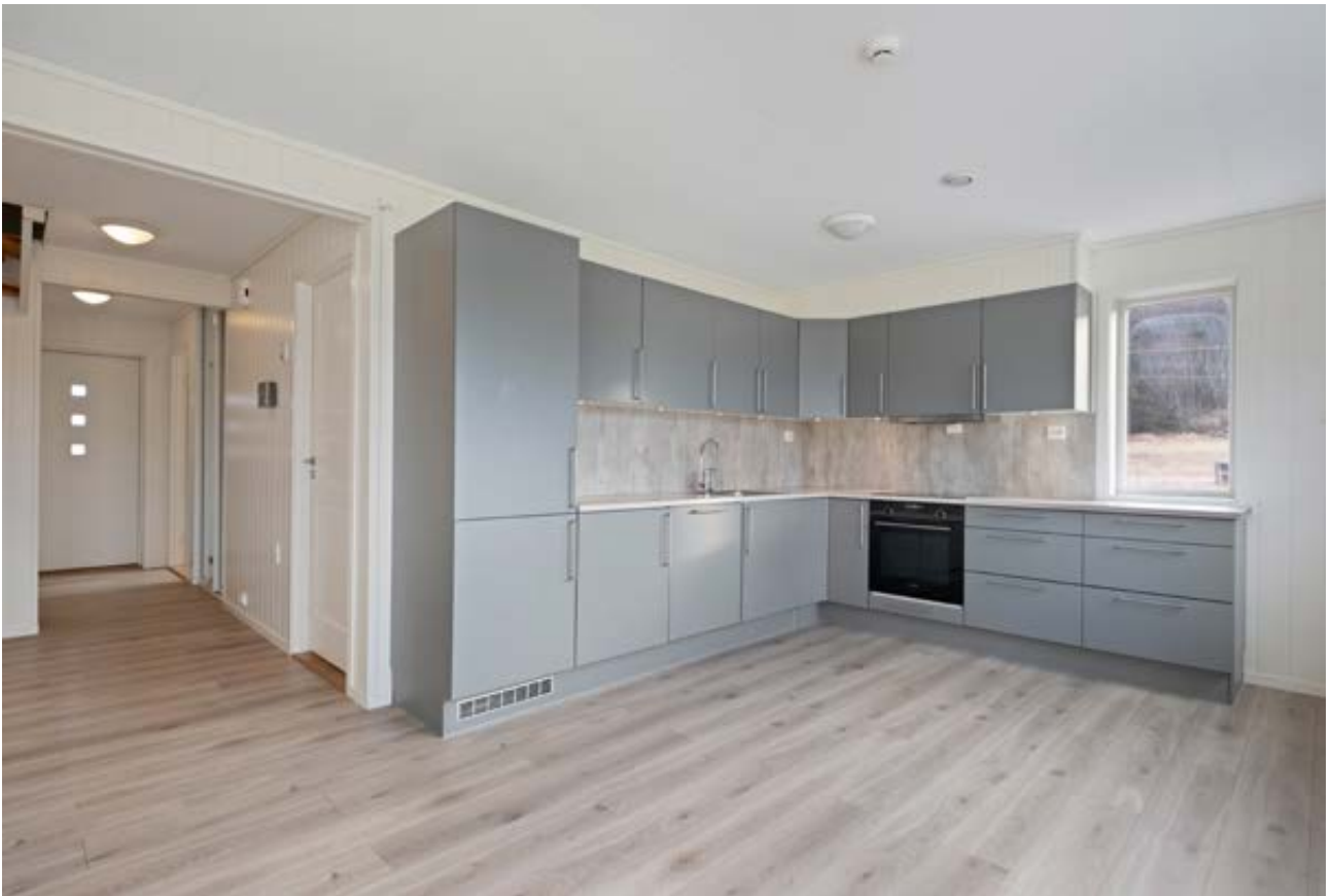
HTH kjøkkeninnredning med hvite glatte fronter og laminat benkeplate med nedfelt 1-1/2 oppvaskkum. Det er fuktbestandige plater på vegg mellom benkeplate og overskap, og spotter under overskapene
