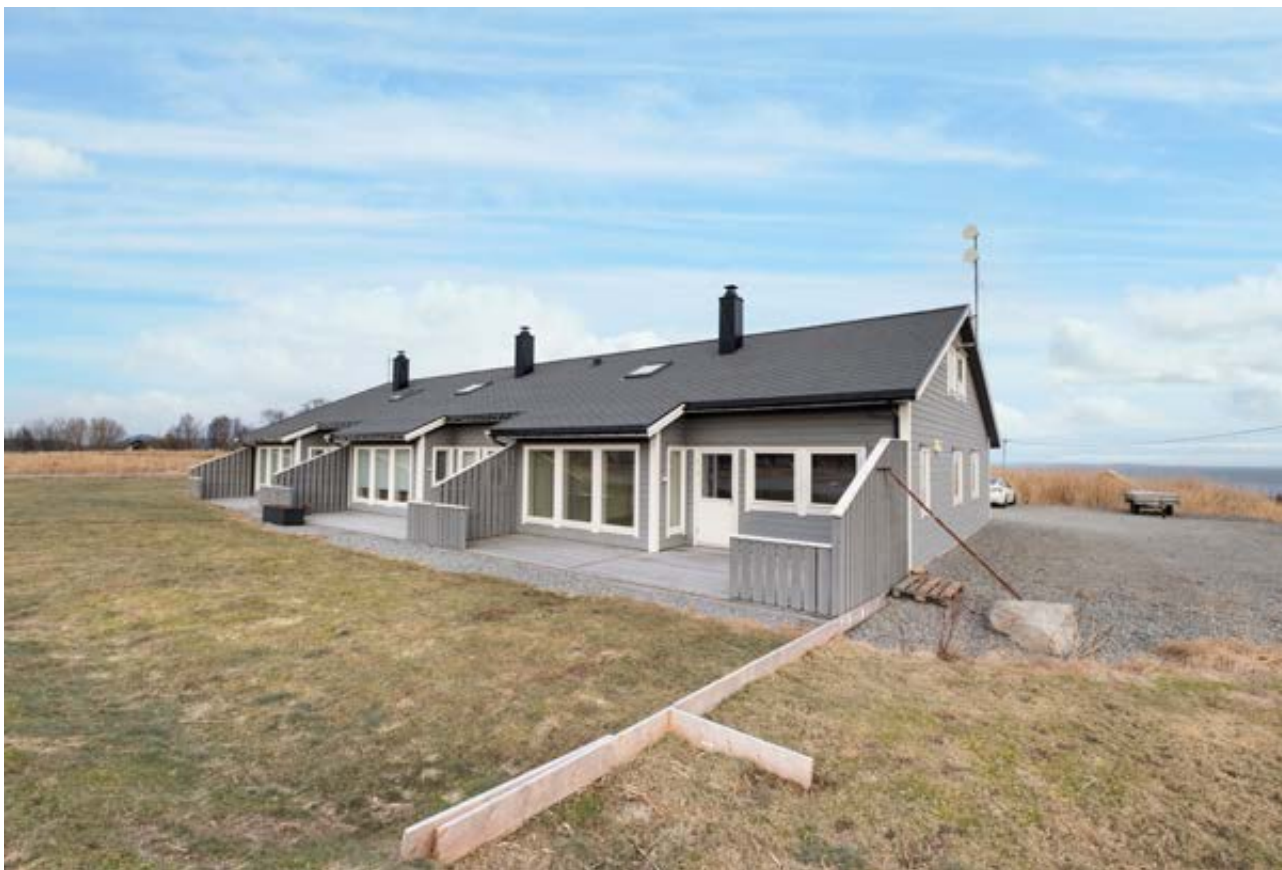
Det er en sydvendt terrasse med terrassebord, levegger og noe trerekkverk. Sameieteier en robotklipper på fellesen
