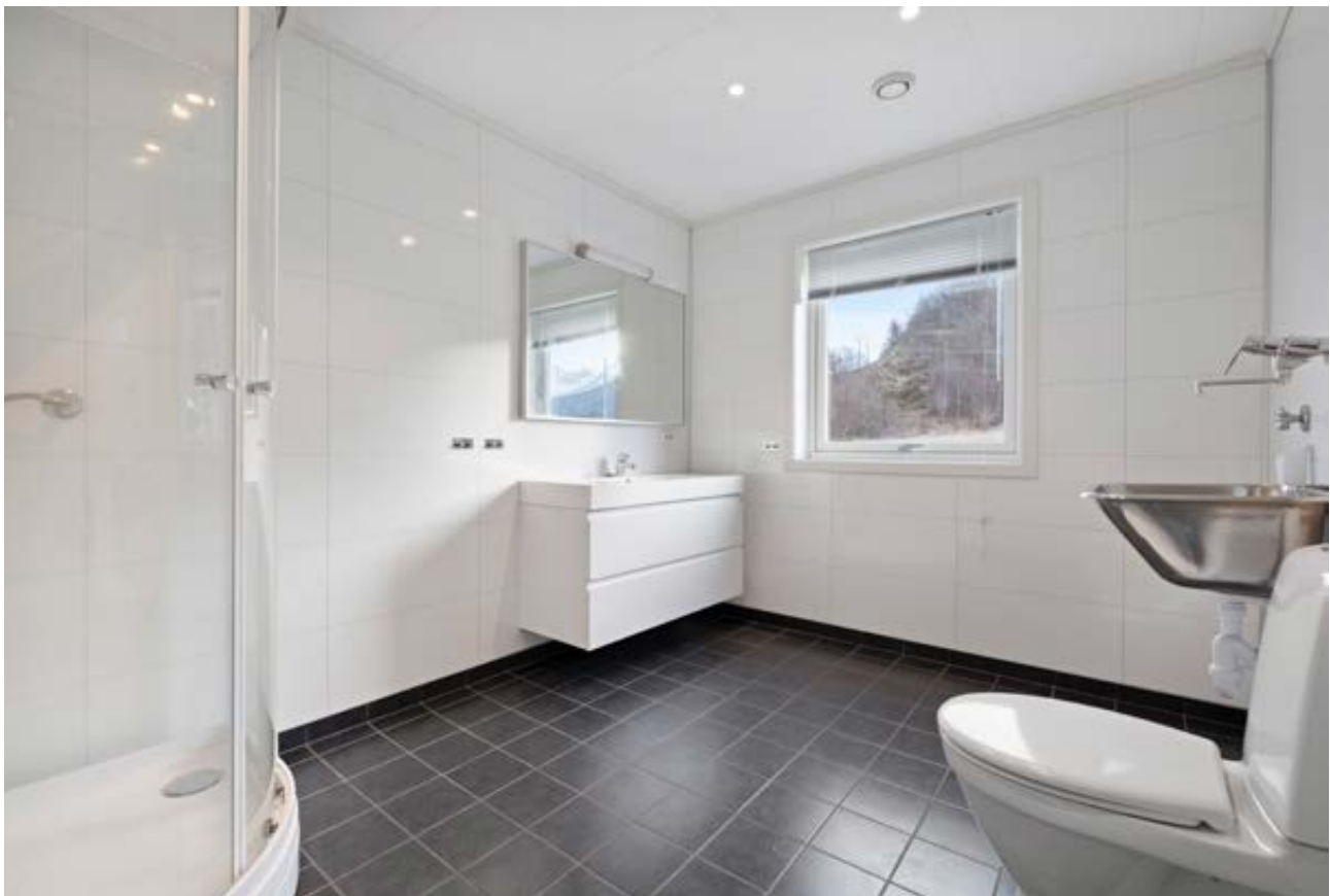
Bad/vaskerom i første etasje har våtromsplater på vegger og flislagt gulv med elektriske varmekabler. Himlingen har hvite himlingsplater. Rommet er utstyrt med servantinnredning med helstøpt kompositt servantplate, stort speil på vegg
