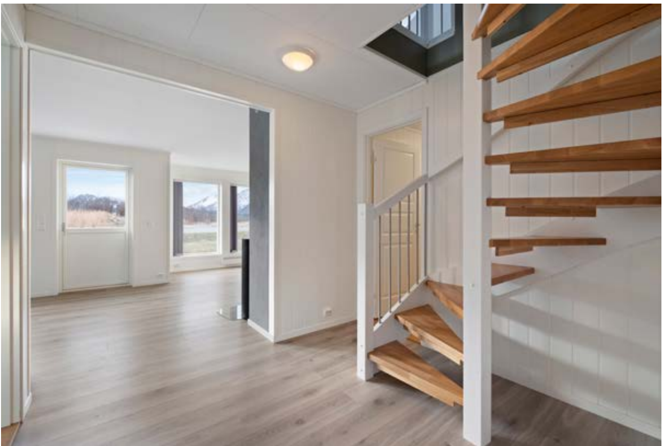
Innvendig trapp i treverk med eiketrinn. Håndlist og rekkverk av treverk med metallspiler
