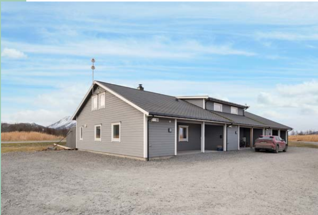
Gruset biloppstillingsplass på felles tomt for sameiet. Det ble montert elbil-lader i 2022
