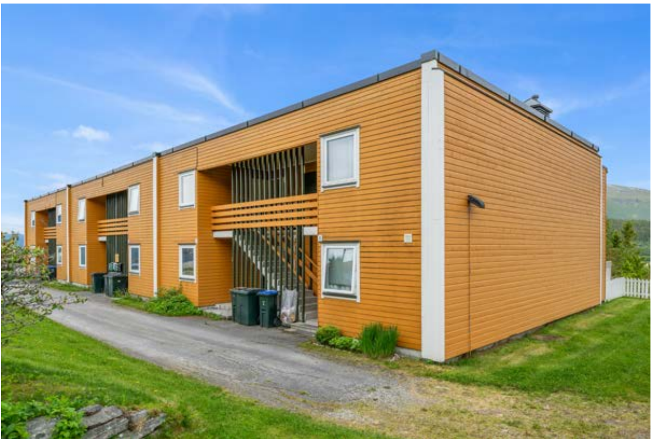
Leiligheten ligger 2. etasje i det etablerte borettslaget Opdølhaugen på Hjelset. Bod med utvendig adkomst ved inngangsparti
