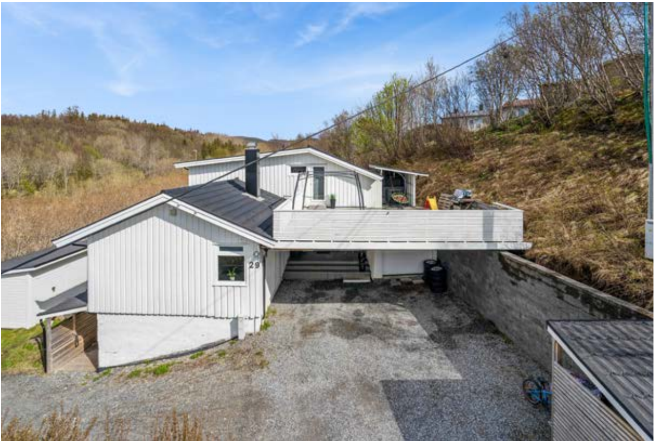
Fasadebilde tatt i front av boligen som viser romslig gårdsplass og terrassen over hovedinngangen
