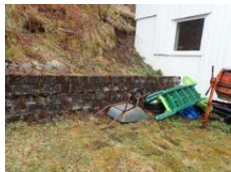
Forstøtningsmur mot terreng på baksiden
