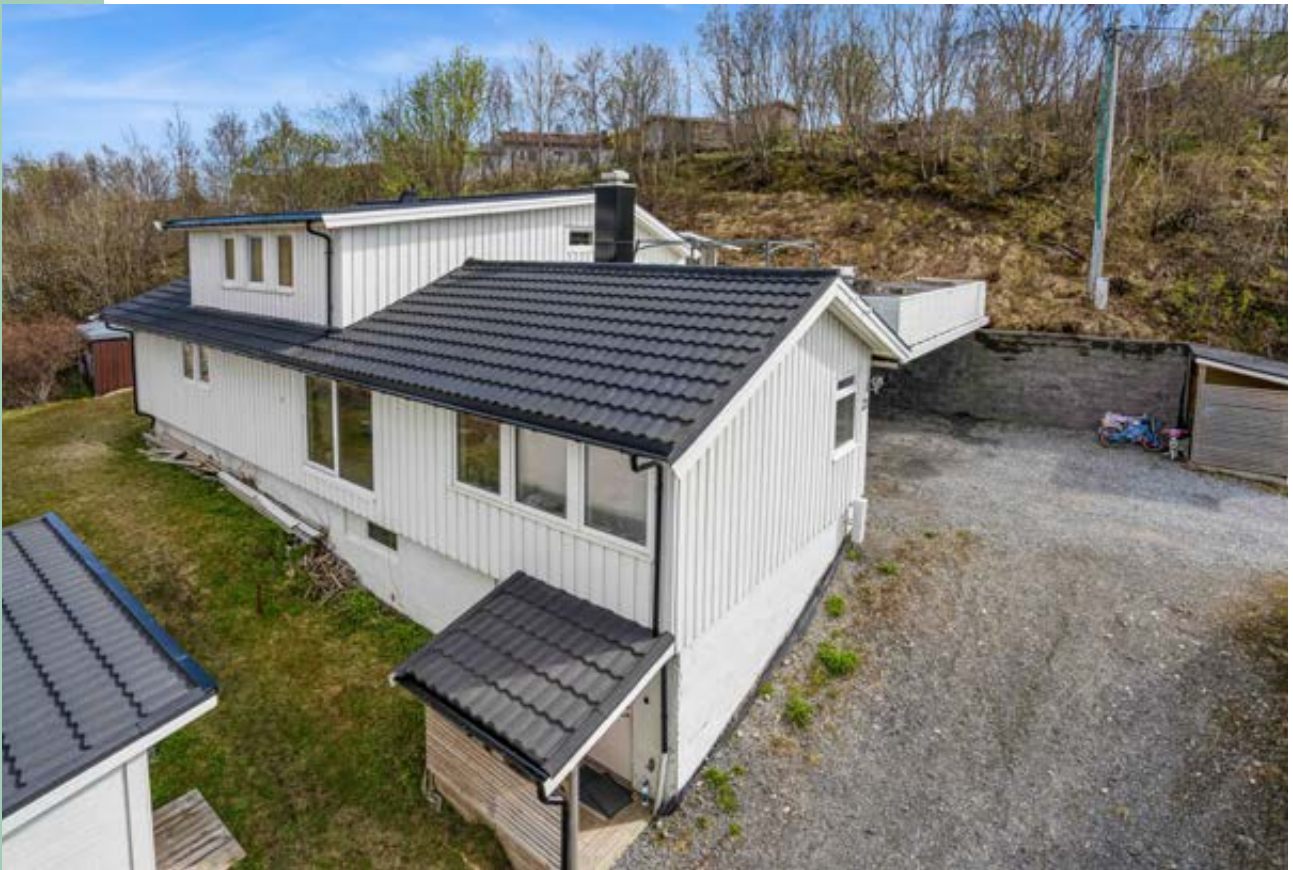
Skråbilde av fasaden m/overbygget inngangsparti hodeddel samt overbygget inngangsparti utleiedel
