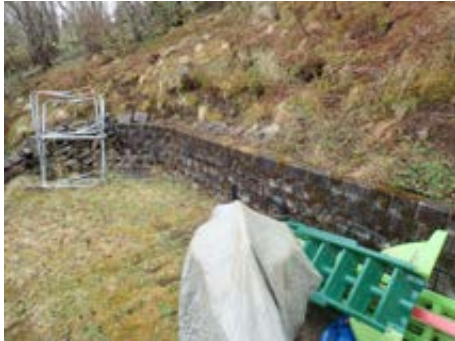
Forstøtningsmur mot terreng på baksiden
