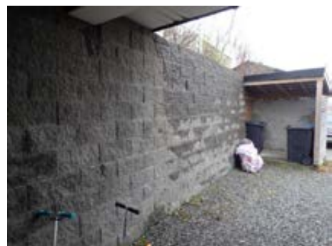
Forstøtningsmur mot terreng ved hovedinngang
