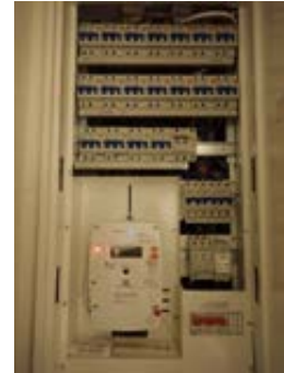
El-skap med 21 kurser over automatsikringer
