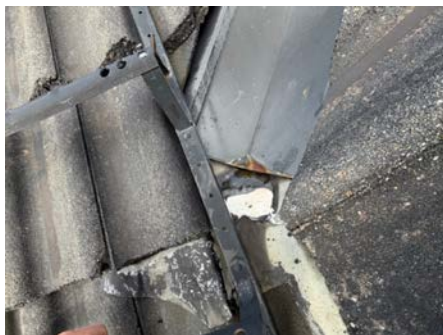
Oversiktsbilde av tidligere lekkasje, tørt nå.
