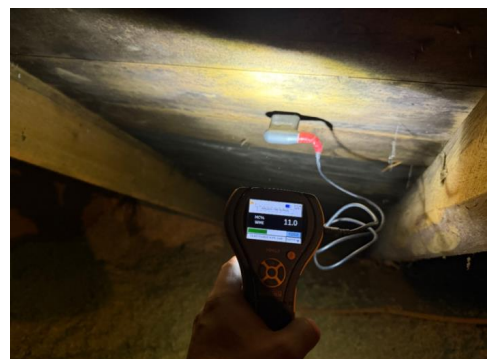
Fuktmåling, ikke utslag på fukt.
