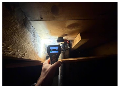
Fuktmåling, ikke utslag på fukt.
