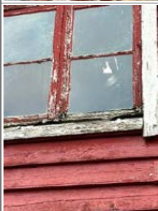
Råteskade vindu
