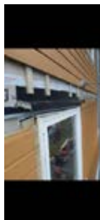
03.07.25: Bilde etter utbedring, overkantbeslag med oppkant begge sider, ført inn bak kledning.
