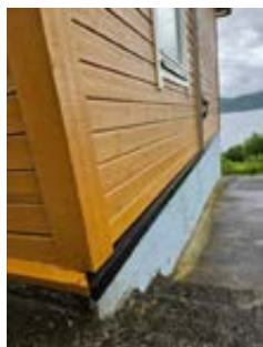
03.07.25: Bilder etter utbedring vannbord/beslag overkant mur, nordvest
