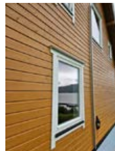
03.07.25: Bilde etter utbedring, oversiktsbilde eksempel vindu nordvegg.
