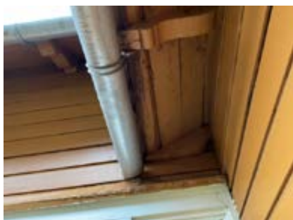
Fukt/råteskade taktro
