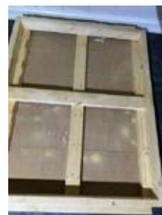
Boremel luke til loft over tilbygg
