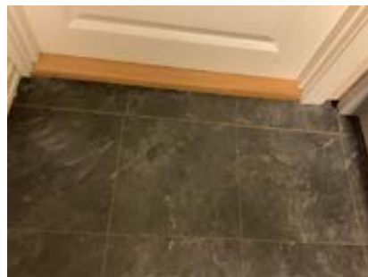
Laminat løsna i skjøt, dekker ikke mot trapp
