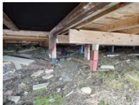
Fundamentering av bjelkelaget
