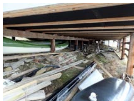
Fundamentering av bjelkelaget
