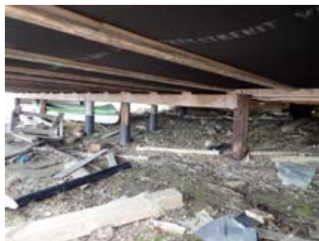
Fundamentering av bjelkelaget
