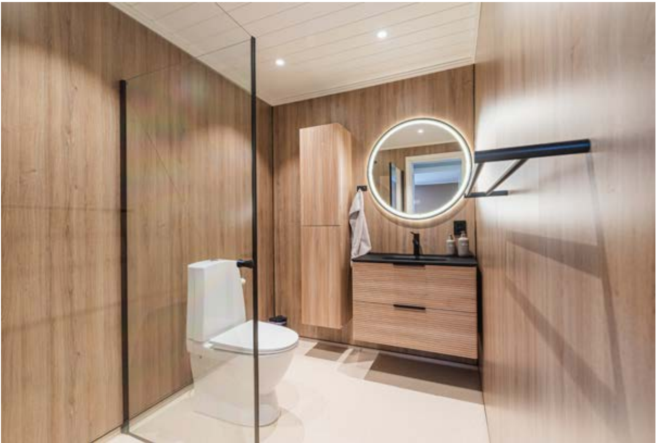
Nybygd bad i underetasjen med baderomsplater på veggene gir et moderne uttrykk, kombinert med vinylbelegg på gulvet.
