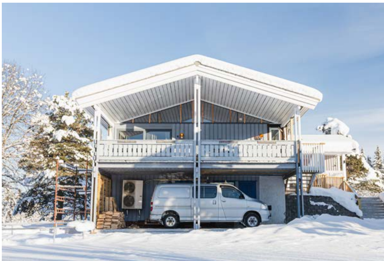
Romslig terrasse i trekonstruksjon med takoverbygg gir ekstra uteplass og praktisk carport under med direkte adkomst til underetasjen.
