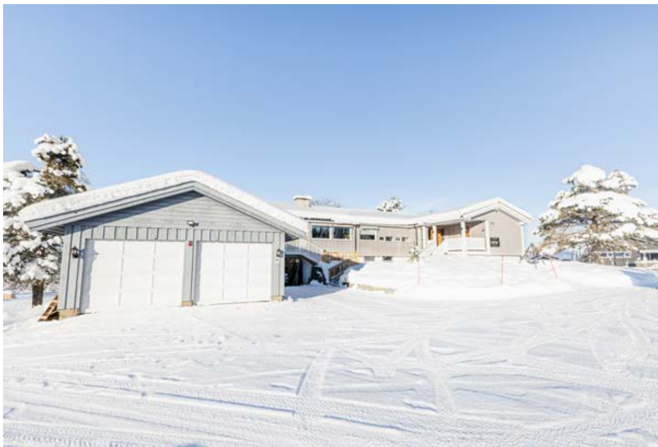
Dobbel garasje gir god plass til parkering og oppbevaring.
