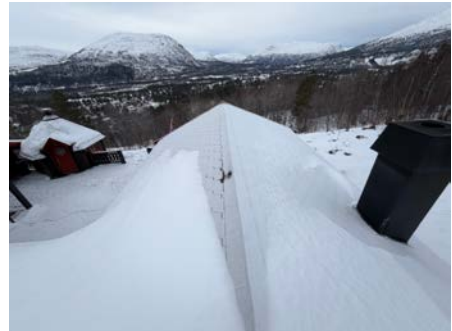
Oversiktsbilde av takteking.
