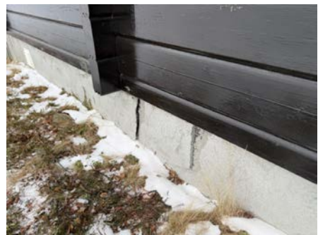
Sprekk i grunnmur og puss.
