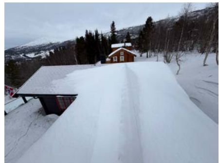
Oversiktsbilde av takteking.
