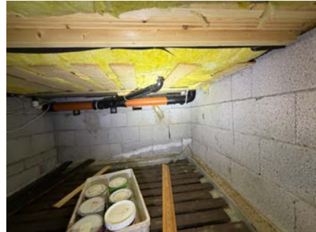
Krypkjeller i tilbygg.
