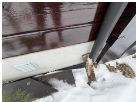
Taknedløp med utslipp i terreng.
