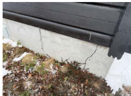
Sprekk i grunnmur og puss.
