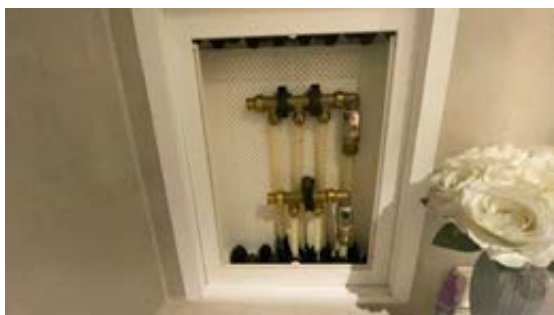
Rørskap på bad i 1. Etasje.
