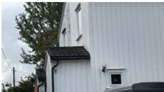
Tak over inngangsparti
