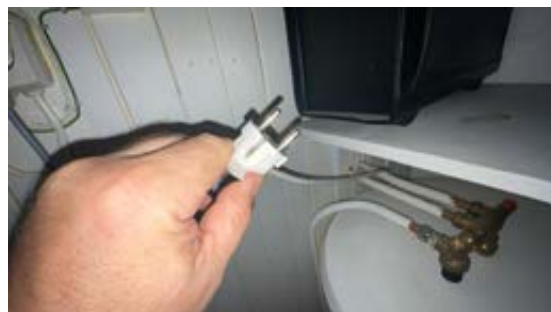
Ingen svimerker på stikk ved dagens befaring.
