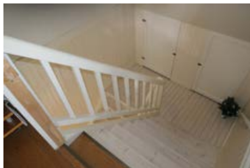
Stor lysåpning på rekkverk.
