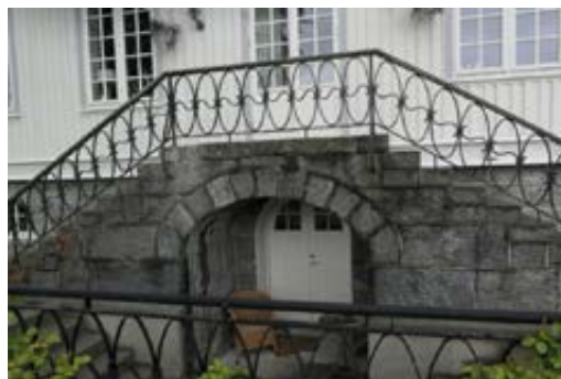
Natursteinstrapp m/smijernsrekkverk syd.
