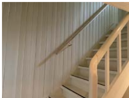
Tretrapp i underetasje.
