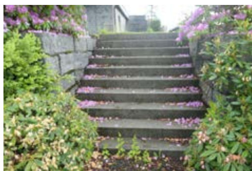
Støpte trapper i hage syd.
