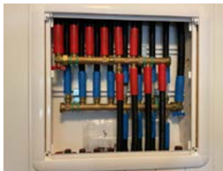
Fordelerskap i underetasje.
