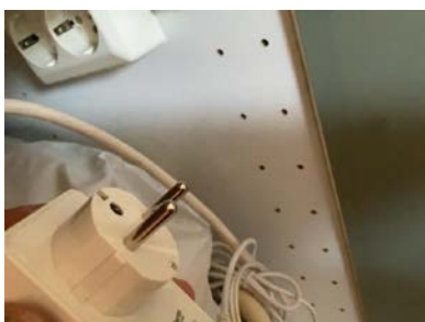
Ikke svimerker på stikk ved dagens befaring.
