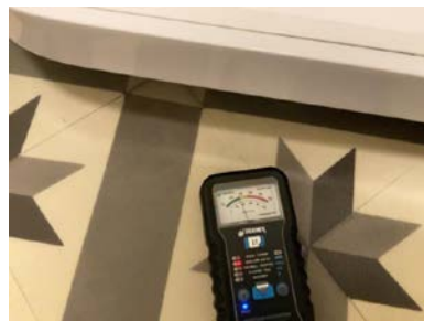
Ingen unormale verdier ved bruk av fuktindikator på gulv/vegger i våtrom.
