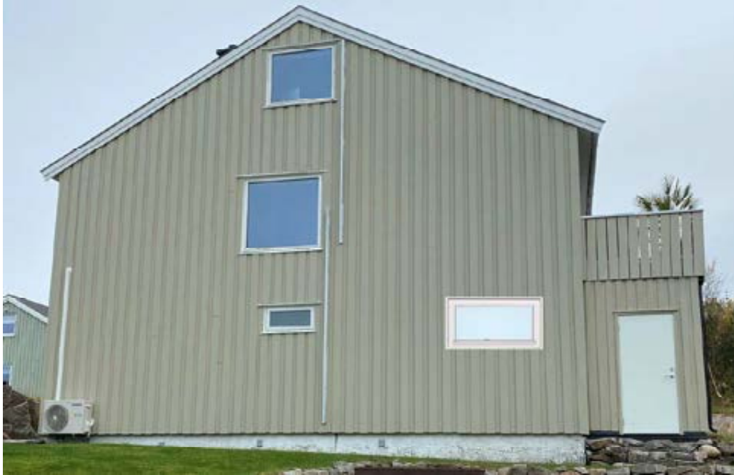
Bilde 1. Gavlføløy Terrasse 17. Plassering av vindu er vist.
