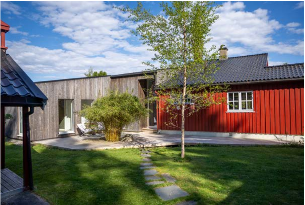
Tilbyggets rolige fasade mot hagen, med brosteinsti, bambus og egen uteplass.
