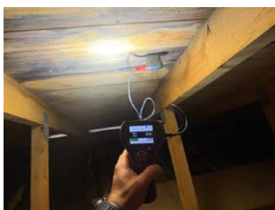
Fuktmåling i undertaket. Ikke utslag på fukt.
