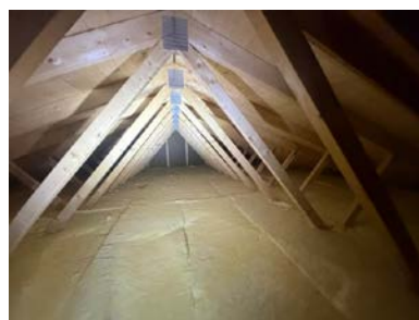
Oversiktsbilde av kaldloftet i tilbygg.
