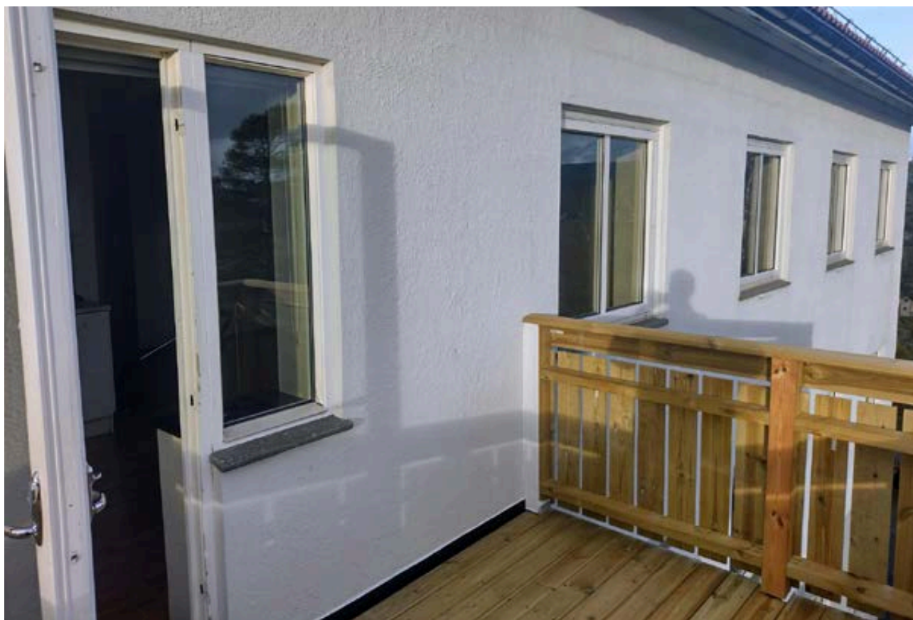
Balkong renoverert høst 2025. Foto: Privat
