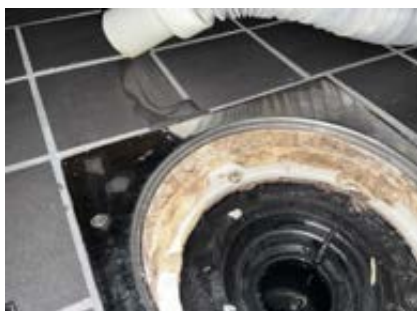
Synlig slukmansjett i sluk under dusj
