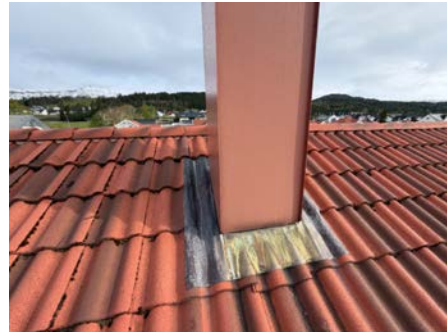
Skorstein over tak.
