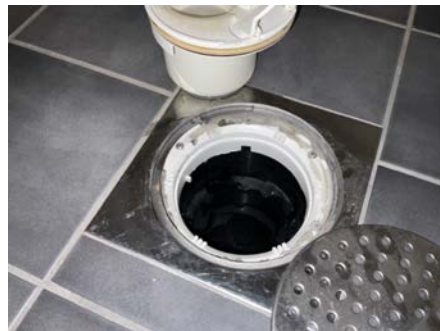
Sluk. Det er synlig membran klemt korrekt under klemringen.
