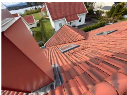
Oversiktsbilde av takflaten mot sør.
