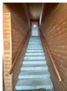
Trapp i betong med hånd-rekke på begge sider.
