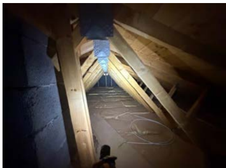
Oversiktsbilde av kaldloftet.
