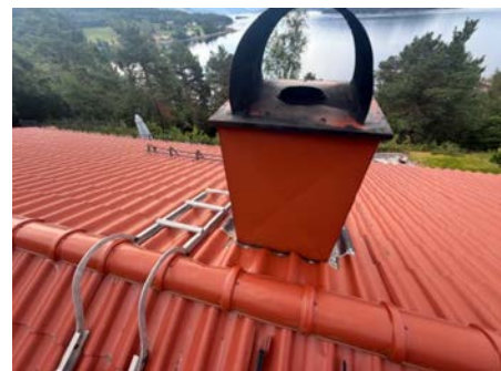
Skorstein over tak.
