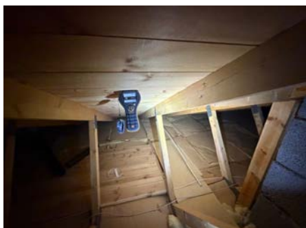
Fuktmåling, ikke utslag på fukt.
