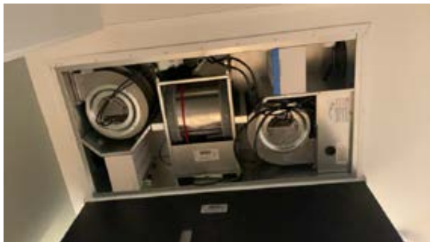
Ensy ventilasjonsaggregat.
