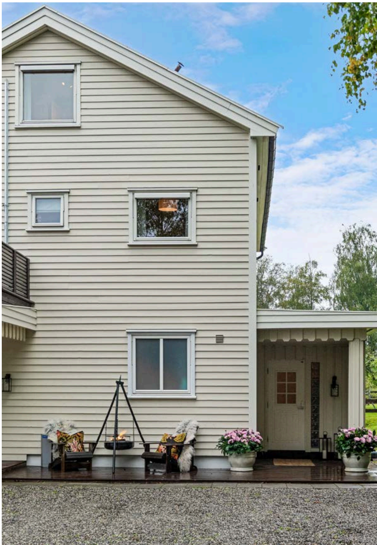
Overbygd inngangsparti og en koselig uteplass.
