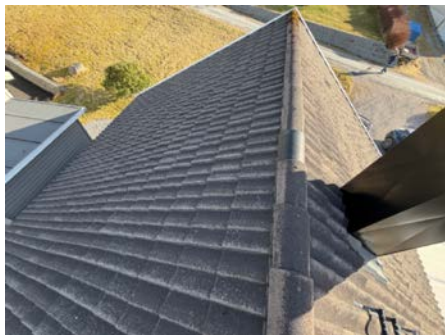
Oversiktsbilde av takteking
