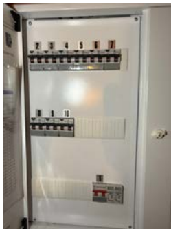
Automatsikringer med skap i kjøkkenvegg.
