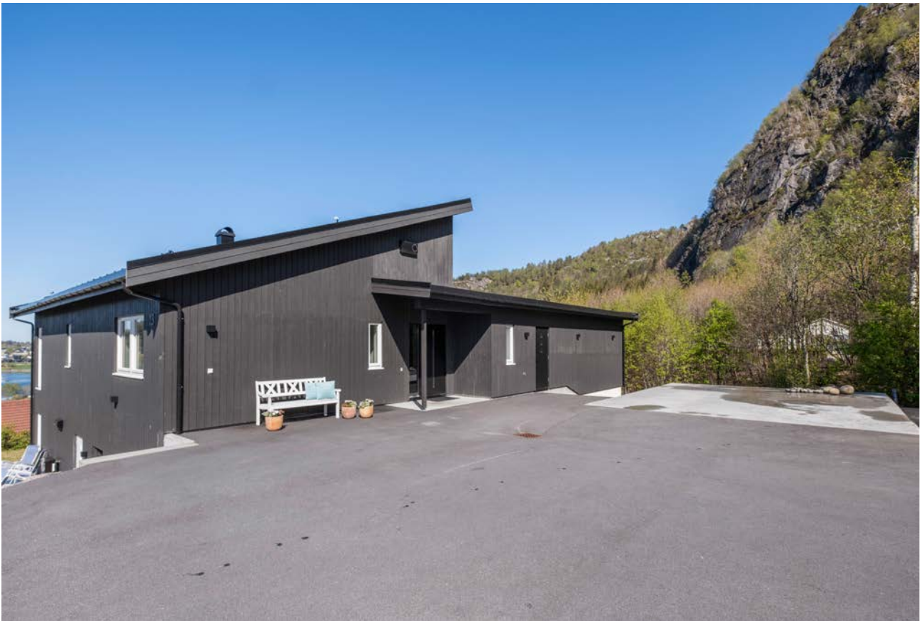
Asfaltert adkomst og tilrettelagt for oppføring av garasje
