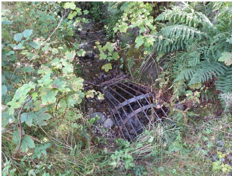
Figur 2: Nærbilde av rør som leder bekken under veg (Leirvågdaalen). Åpningen er sikret med gitter.
