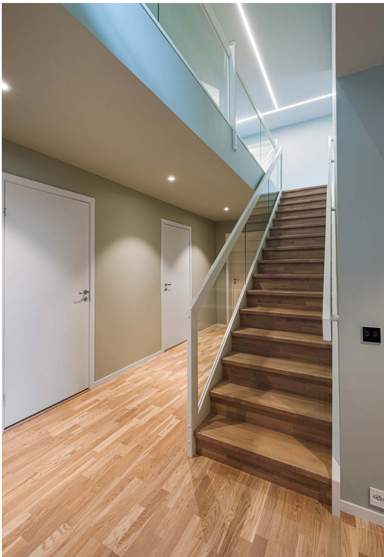
Tett trapp mellom etasjene er utstyrt med håndløpere og glassrekkverk
