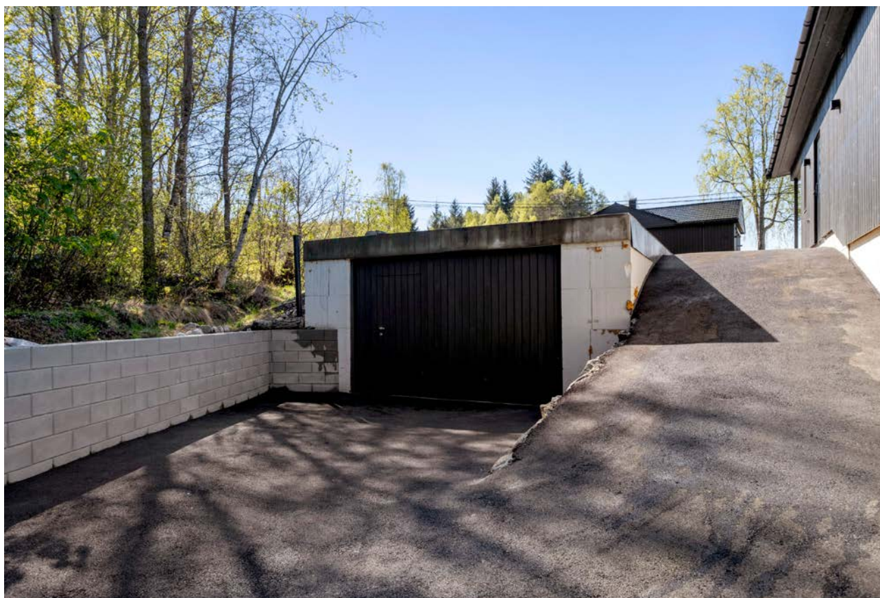
Garasjen/uteboden fra 2022 har en manuell port og er lokalisert på sørøstsiden av boligen. Det er lagt frem strøm til boden
