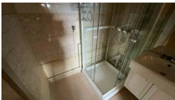
Synlig opplegg av kobber fra byggeår
