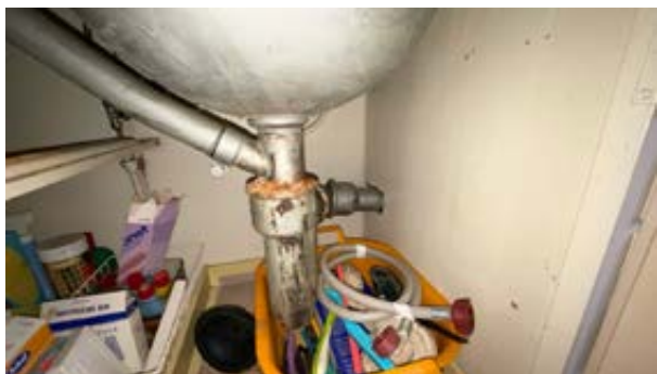
Gammel røropplegg av støpejern
