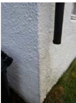
Taknedløp nordside avsluttet over bakkenivå
