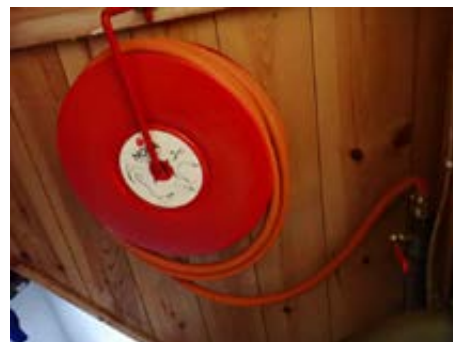
Stoppekrane og brannslange i kott ved lite soverom.
