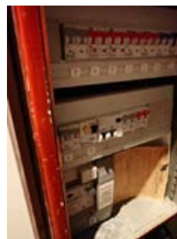
Sikringsskap oppgradert med automatsikringer
