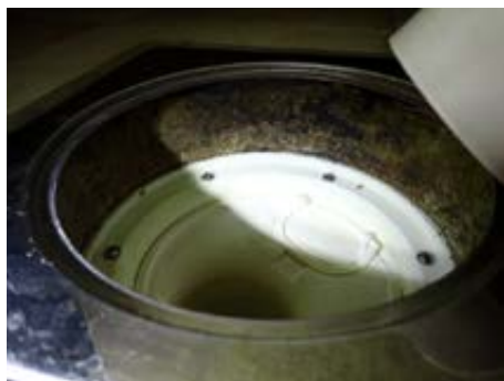
Sluk ved toalett
