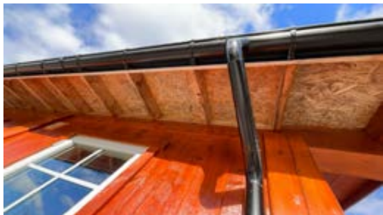
Synlig lufting ved takrennekroker.
