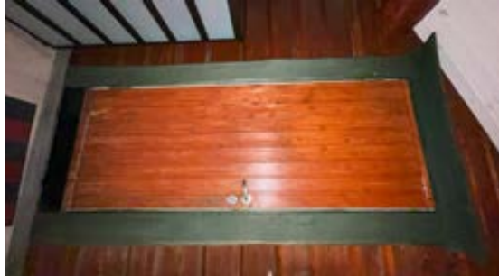
Dør mellom oprinnelig hytte og gang fra 1996.
