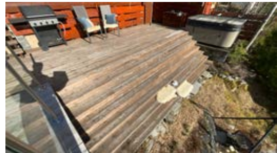
Trapp ved opprinnelig hytte.
