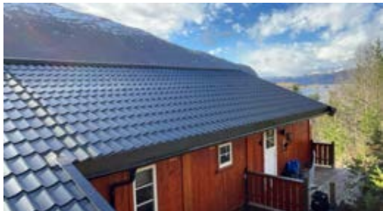
Oversiktsbilde på nordsiden av bygget. Viser takteking på tilbygg oppført i 2013
