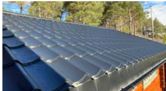
Oversiktsbilde på sørside av opprinnelig bygg. Viser takteking på opprinnelig bygg fra 1996 som ble byttet i forbindelse med oppføring av tilbygg i 2013.
