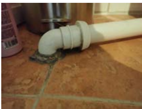
Rørgjennomføring i gulv.
