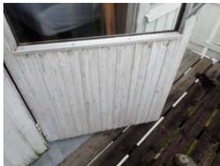
Altandør på loft
