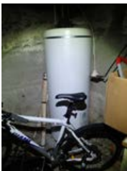
Vvb med el-tilkoblet via stikkontakt
