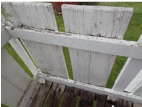
Råteskadet rekkverk
