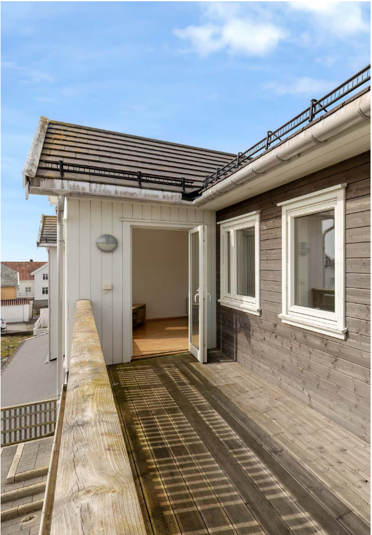
Vinduer fra byggeåret er i normal stand og har alminnelig vedlikeholdsbehov.
