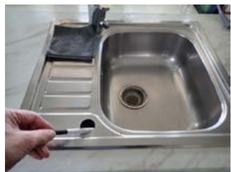
Hull på beslag bør tettes
