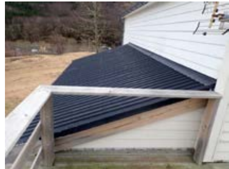
Tak over inngangsparti
