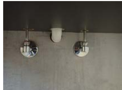
Vann/avløp til/fra servant. Åpent hull i vegg
