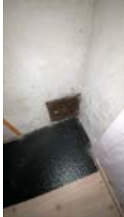
Montert plate på gulv ved sotluke
