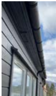
2 lufte punkter på hver langside av bygget er synlig i raftekasse
