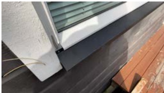
Beslaget under stuevinduet er montert på utsiden av vinduskarmen.
