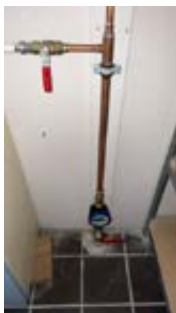
Hovedstoppekrane og vannmåler
