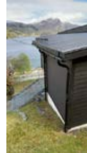
Takvann er ført til skjult avløp i terreng
