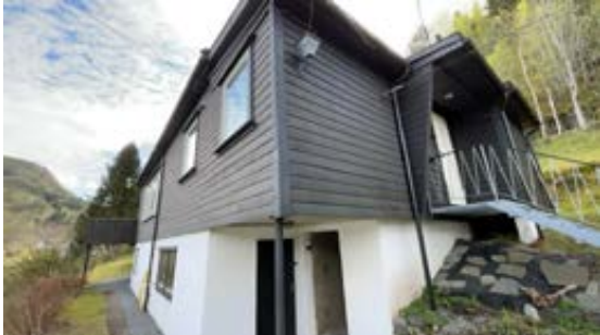
Oversikt kledning som er skiftet
