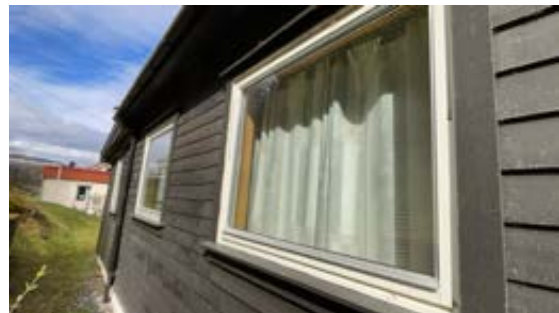
Vinduer på soverom og kjøkken
