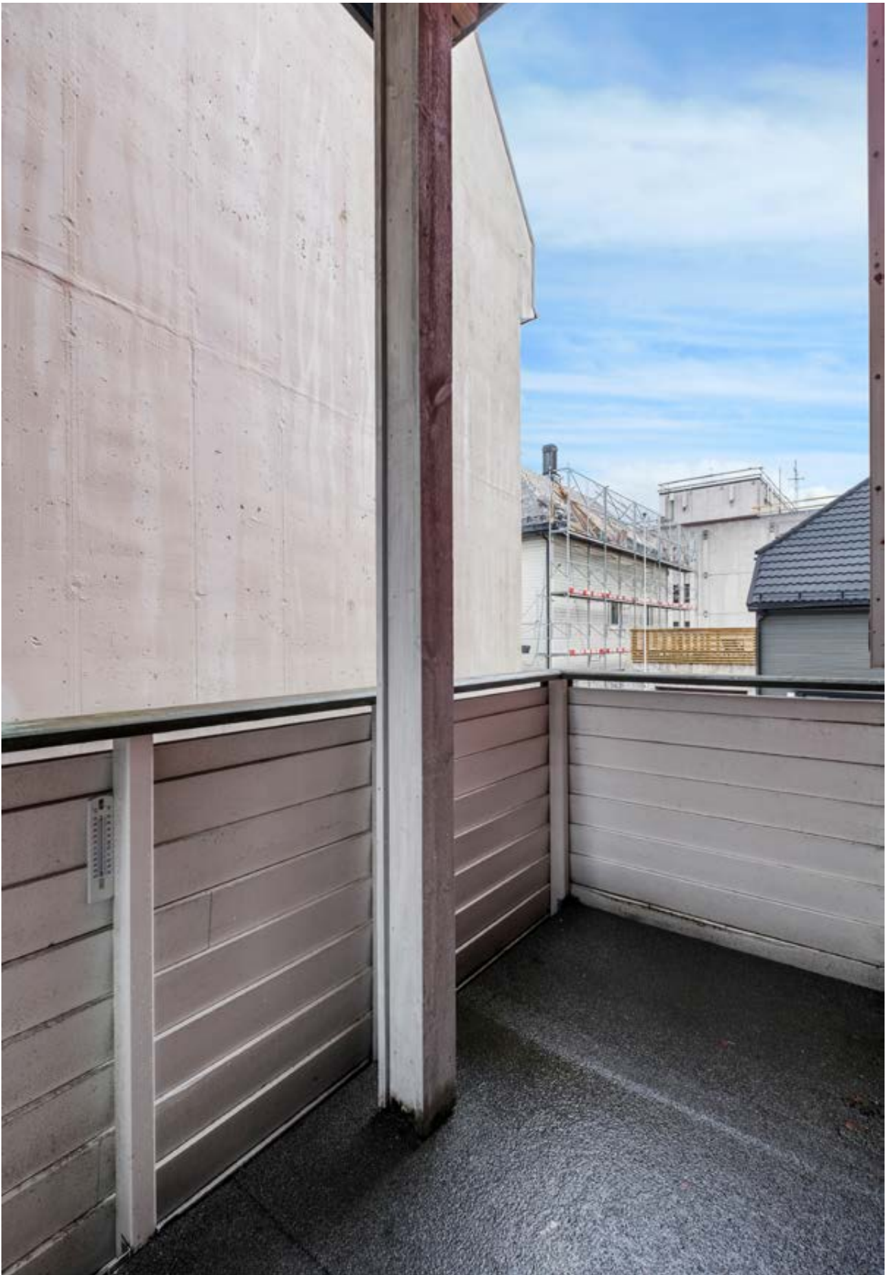
Overbygd balkong mot øst
