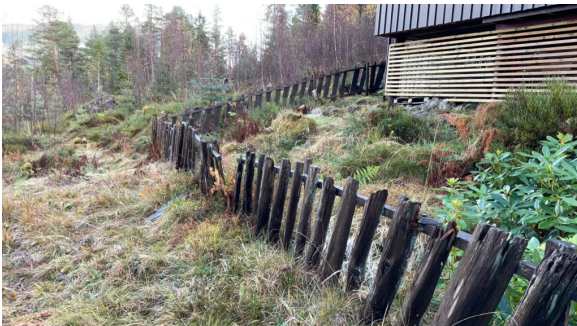
Gjerde i dårlig forfatning
