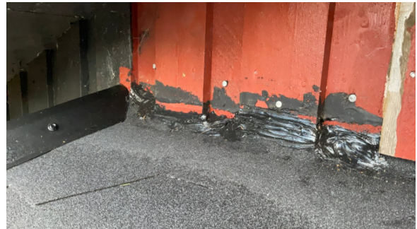
Overgang taktekking-vegg, tak over tilbygg 1997
