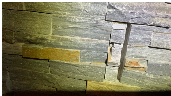
Gliper mellom element, bruk av mindre element
