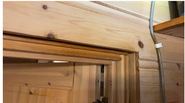
Eksempel gjenstående arbeid
