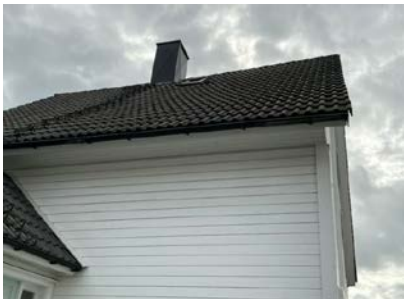
Pipe er dekket med beslag over tak.
