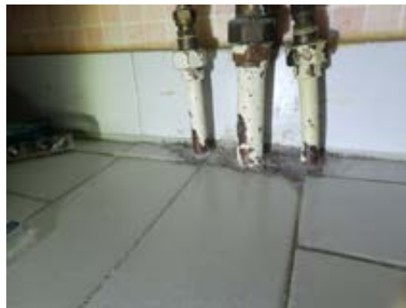
Utett rørgjennomføring
