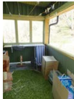
Overbygget altan/terrasse i 2.etg
