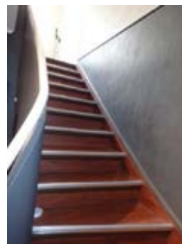
Trapp mellom 1.etg og 2.etg. Ikke håndlist
