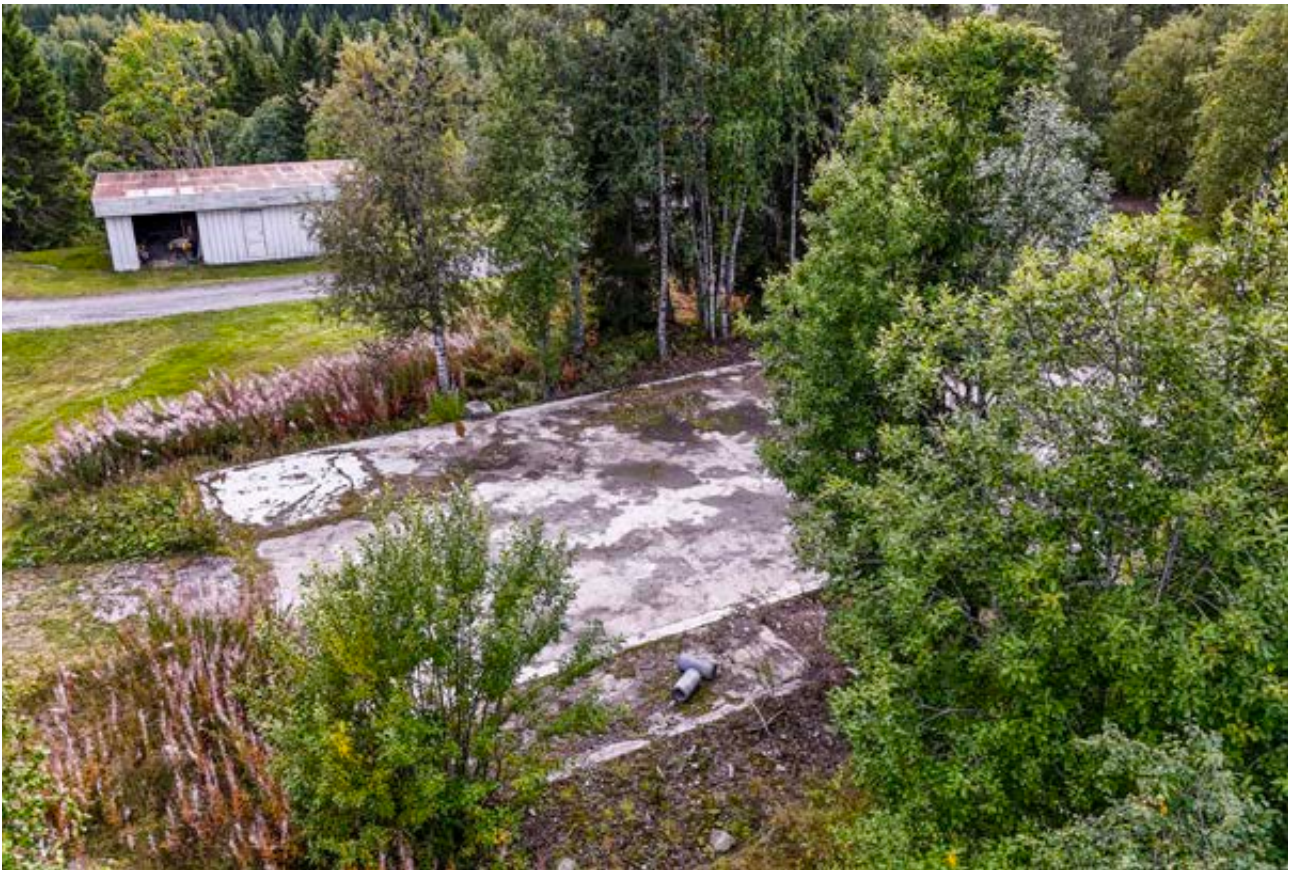
Den store støpte platen er rester fra revet garasje/uthus som gir muligheter for flere bruksområder. Hundegård/drivhus/ parkering eller en ny garasje. Foto-Olsen
